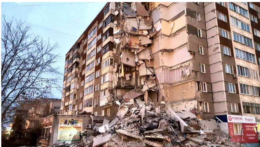
Рисунок 1. Обрушение здания в процессе эксплуатации
