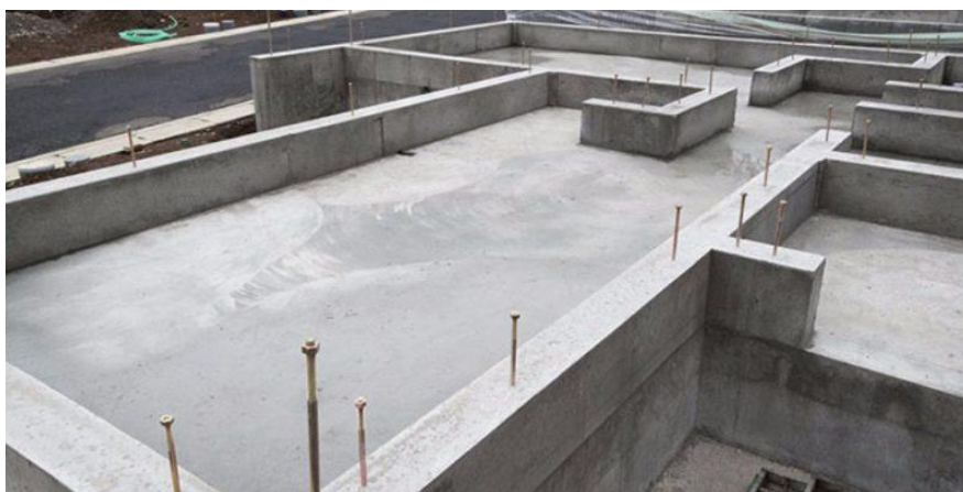
Рисунок 1 Монолитные железобетонные конструкции
