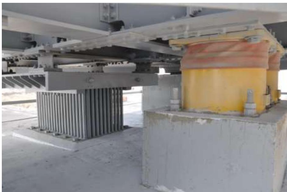
Рисунок 3 – Пример использования демпферных устройств
