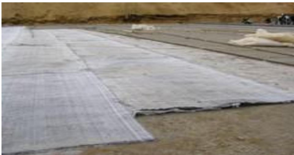
Рисунок 1 - Гидроизоляционные бентонитовые маты
