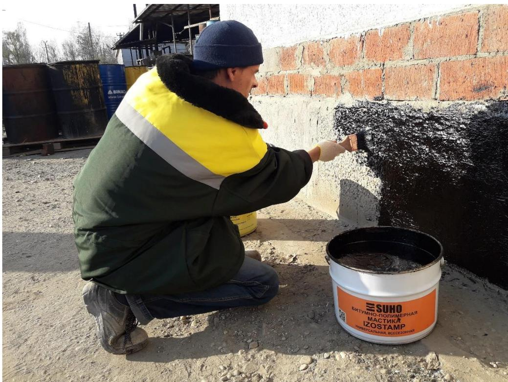
Рисунок 3 - Нанесение полимерно-битумной мастики
