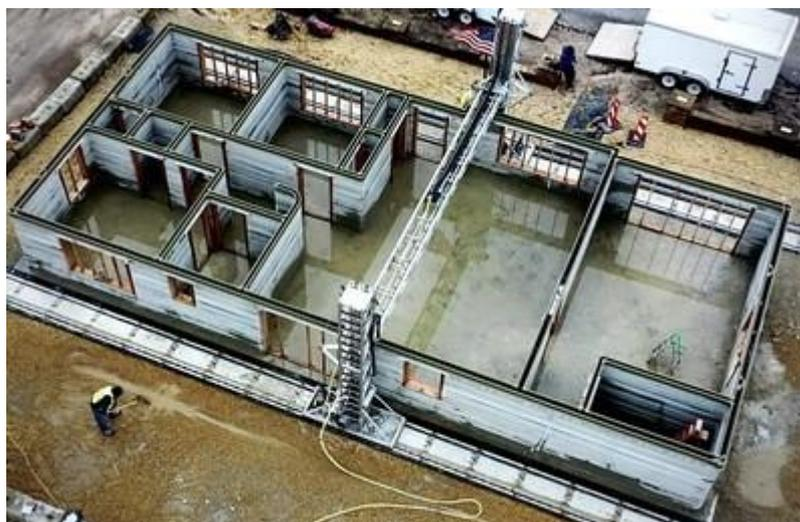
Рисунок 2 - Создание дома с помощью 3D-принтера
